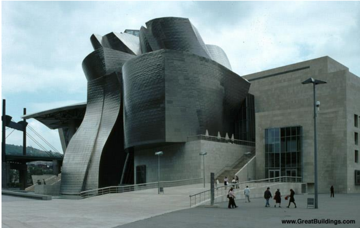
Gambar 59 Museum Guggenheim Bilbao, Spanyol, dirancang oleh Frank O. Gehry dengan bantuan komputer. Bentuk yang tak beraturan ke arah tiga sumbu memerlukan bantuan komputer untuk menyelesaikannya. 18
